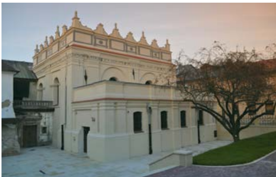
Synagoga w Zamościu – stan obecny. Na początku XVII w. zamojscy Żydzi rozpoczęli budowę nowej, murowanej synagogi. Dziś w tej synagodze (przy ul. Zamenhofs, dawniej Żydowskiej), znajduje się muzeum żydowskiego miasta (Centrum „Synagoga” Fundacji Ochrony Dziedzictwa Żydowskiego).
