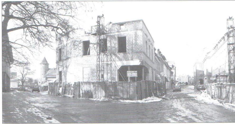
22. Rekonstrukcja budowli w roku 1993
